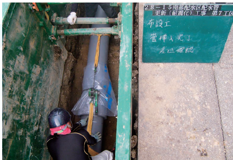
配水管の耐震化工事
