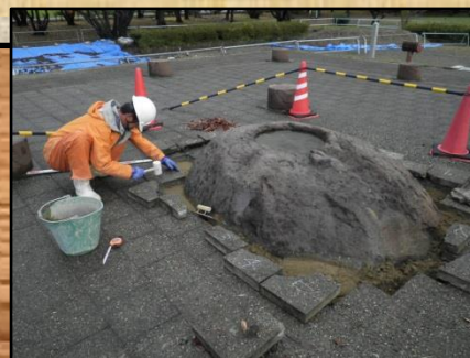
保存修理の様子
