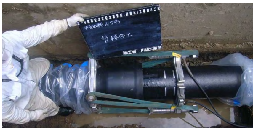
写真 耐震管への更新風景
