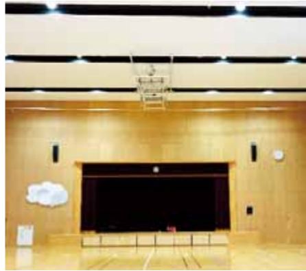
野々市小学校体育館の吊り天井
