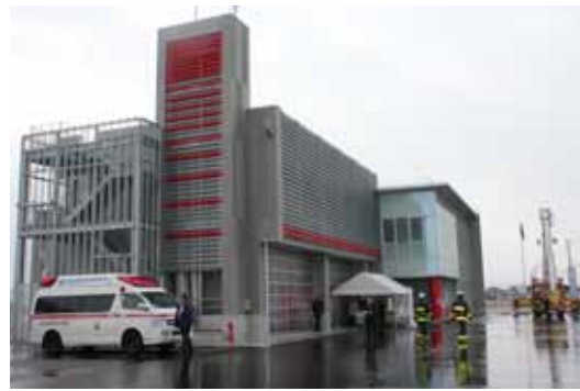
美川消防署 外観
