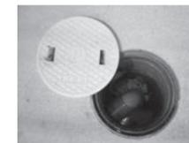
ますを設置して、油分を溜める構造になっています。溜まった油分は定期的にひしゃくなどで取り除き、水気を切って一般ごみとして処分してください。また、宅地内の排水管には点検口となる15cm程度の小口径ますが数カ所設置されています。このますも、定期的にマイナスドライバーなどで蓋を開けて、汚れがひどい場合は清掃しましょう。
