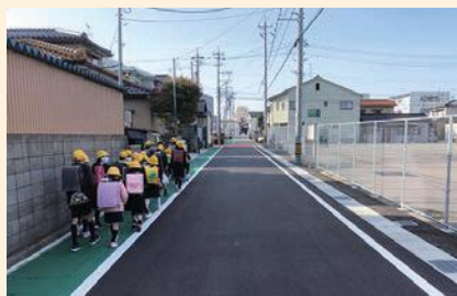
完成した現地
