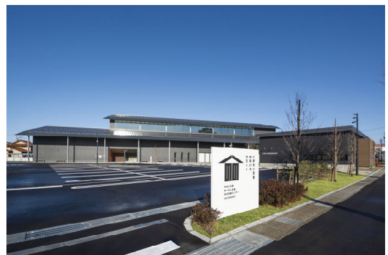
平成 31 年 にぎわいの里ののいちカミーノ完成
