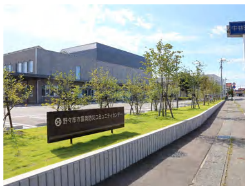
▲富奥防災コミュニティセンター
