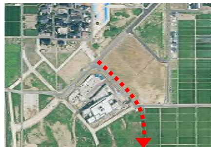
▲(都)野々市中央公園西線の整備
