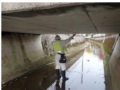
日常的維持管理（橋下面）
