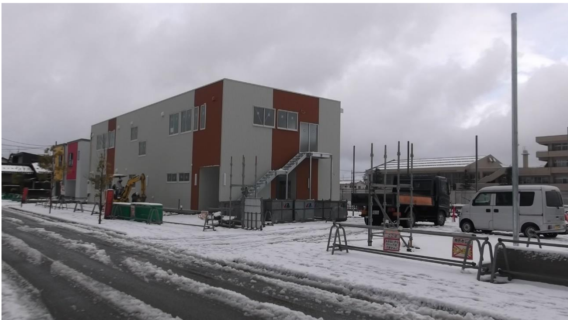
令和3年2月17日現在現場写真
