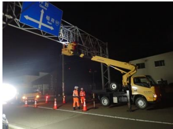
高所作業車での近接目視
