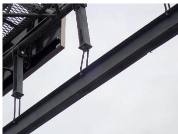
高さ制限装置取付部の変形
