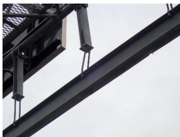
高さ制限装置取付部の変形
