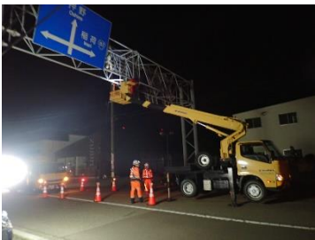
高所作業車での近接目視
