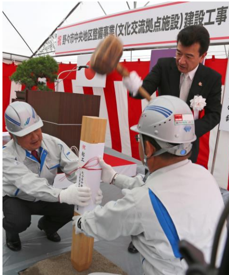
7月27日 文化交流拠点施設起工式にて 「杭打ち」をする栗市長
