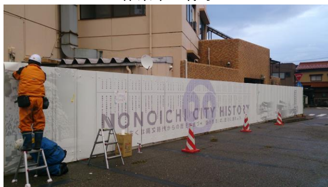
作業中の様子
